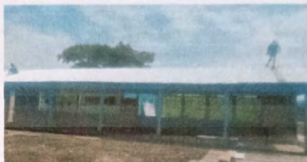
Foto 2: se instala lamina Trokelada
