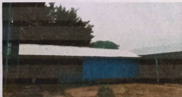
Foto 5: se colocó lamina Trokelada asegurado con tornillos 2" x 3/16"
