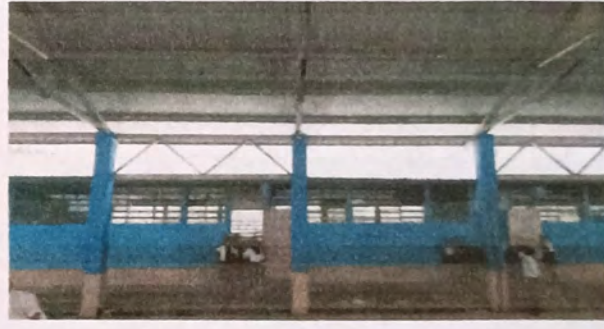
Foto 4: se colocó lamina Trokelada con pistole de impacto
